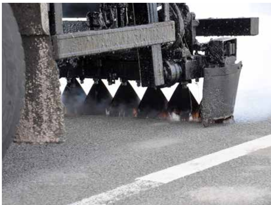
De verjongingscrème wordt op het bestaande wegdek gespoten
