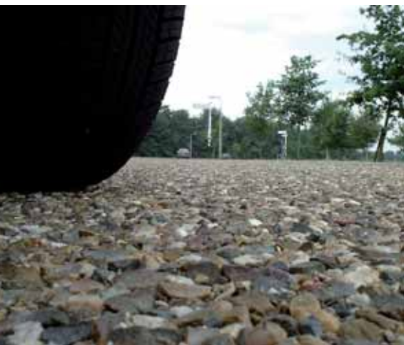
Goed mozaïek zorgt voor aaneengesloten oppervlak.
