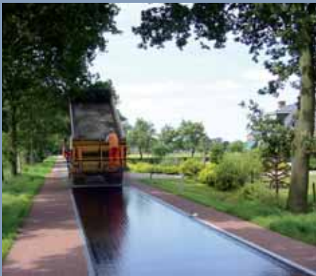
Afstrooien met steenslag tussen de met rode steenslag afgestrooide fietssuggestiestroken.
