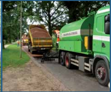
Rode steenslag voor een fietssuggestiestrook.
