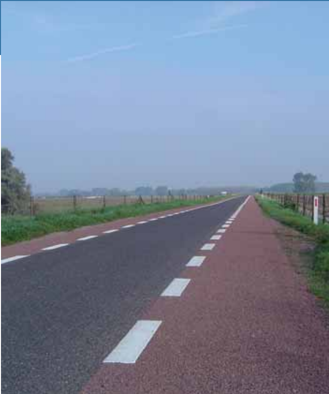
Duurzame oppervlakbehandeling met fietssuggestiestroken.
