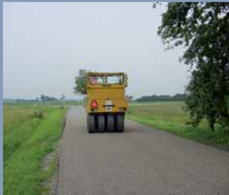
Walsen met bandenwals voor een goed aaneengesloten oppervlak.
